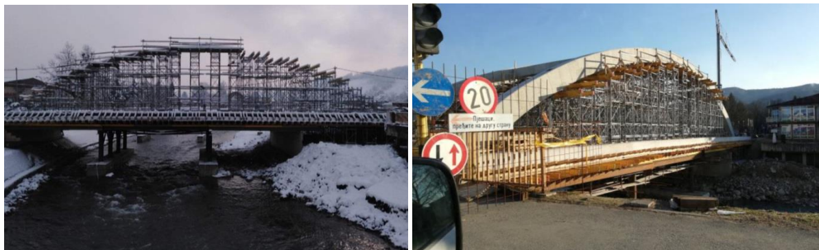
Slika 5.3.4. Izgradnja novog mosta u centru opštine Čelinac na lokaciji uklonjenog mosta – investiciona mjera u realizaciji – finansira opština Čelinac uz pomoć Vlade Republike Srpske
