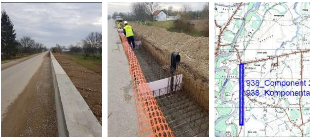
Slika 5.3.1. Podizanje nivoa zaštite na postojećem desnom vrbaskom nasipu u Prijebljezima - izgradnjaparapetnog zida – investiciona mjera u realizaciji (izvor: TG28 – Hitne mjere na umanjeњу poplavnog rizika u Republici Srpskoj)
