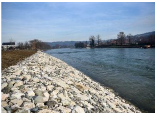
Slika 5.3.3. Uređenje vodnog režima i korita Vrbasa u Gradu Banja Luka – investiciona mjera u realizaciji na oglednoj - pilot dionici
